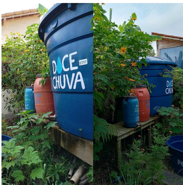
Figura 14: Caixas d'água que compõem o projeto Doce Chuva Fonte: Trabalho de campo, outubro de 2023
