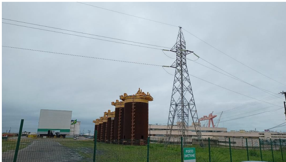
Figura 10: Porto da Imetame em construção, ao lado do Estaleiro Jurong, à direita. Vista da rodovia Fonte: Trabalho de campo, outubro de 2023.
