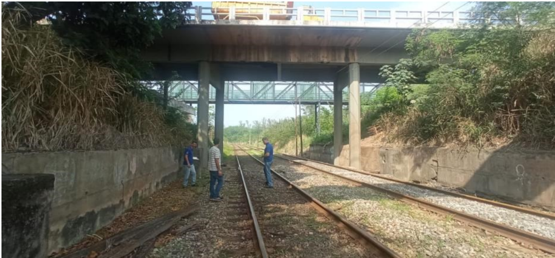
Figura 2 - Vista sob viadutos da Rodovia BR-465 e ciclovia em Seropédica (RJ). Deste ângulo, a área destinada à nova ferrovia ficaria à esquerda das existentes.
