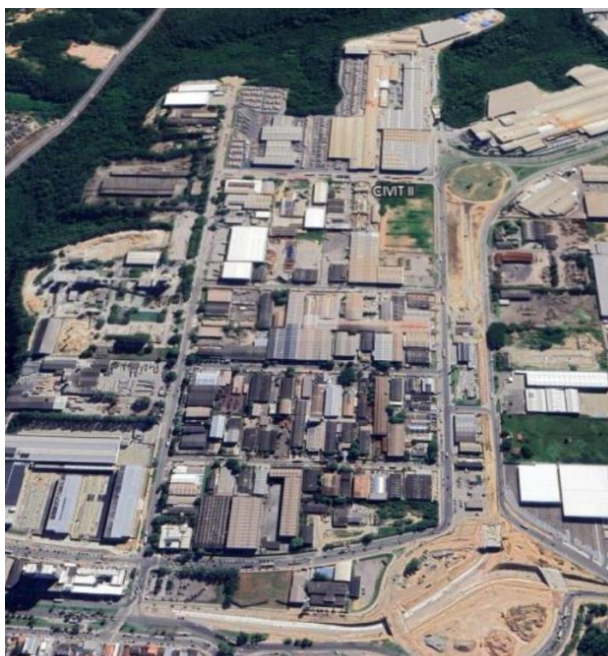
Figura 4: O Centro Industrial CIVIT II e a “Rotatória do O” (inferior direita) em obras, Serra/ES
