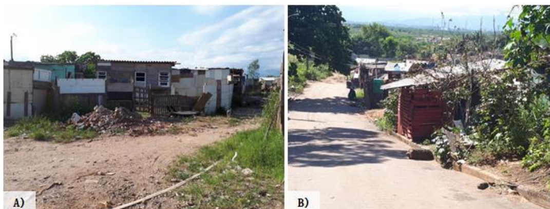
Figura 2 - Moradias improvisadas na área de ocupação recente de Jardim Gramacho, Duque de Caxias/RJ. Fonte: Arquivo fotográfico dos autores registrado em 10/04/2018.
