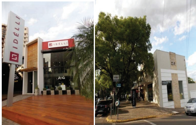
Figura 5. Fachadas de lojas da Nova Centralidade. Observa-se um desenho arquitetônico padrão, com formas retas e funcionais, segue tendências internacionais análogas à áreas nobres de grandes centros de consumo.
