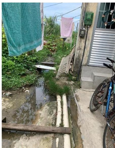
**Figura 8:** Foto de saídas de esgoto lançado diretamente no terreno alagado. Fonte: Próprio autor.
